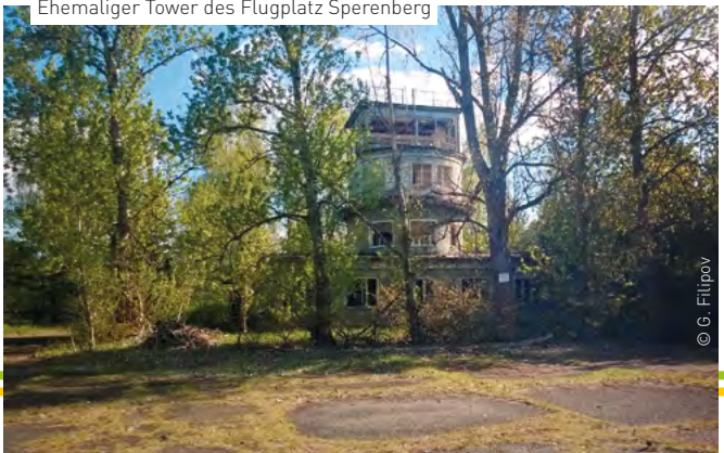
Ehemaliger Tower des Flugplatz Sperenberg
